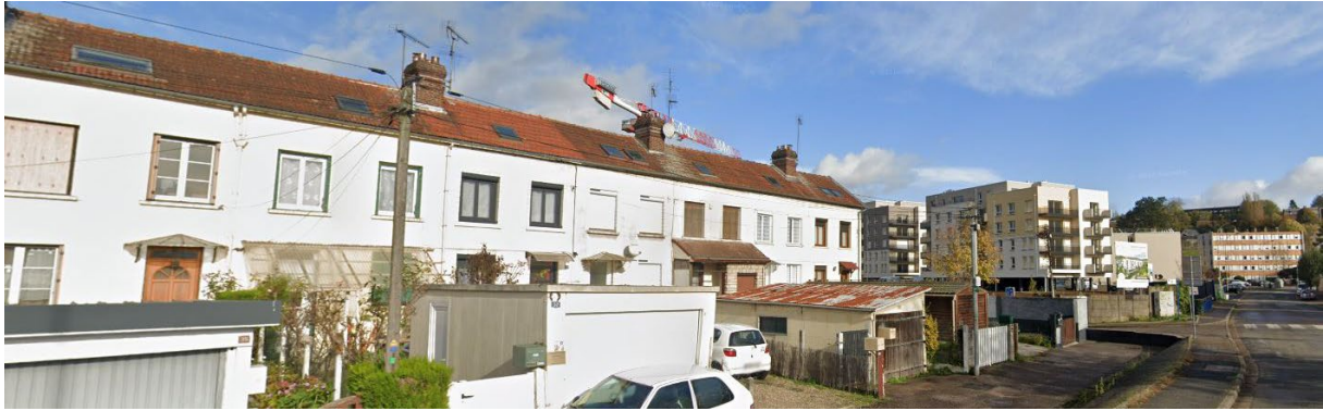
Photographies des logements face au terrain au Nord
